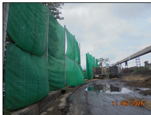
รูปที่ 10 ตาข่ายชะลอลมและดักฝุ่นรอบบริเวณลานกองเก็บขนำอ้อย
