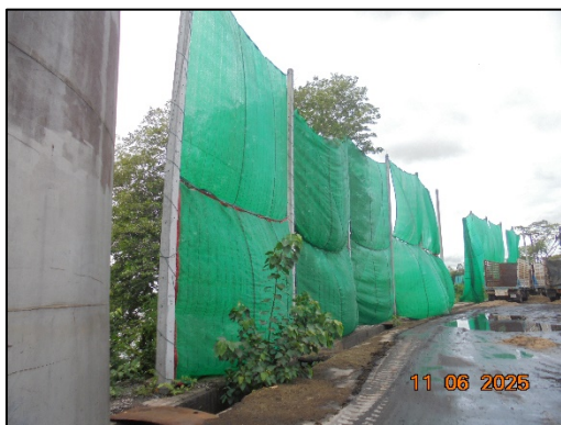
รูปที่ 10 ตาข่ายชะลอลมและดักฝุ่นรอบบริเวณลานกองเก็บขนำอ้อย
