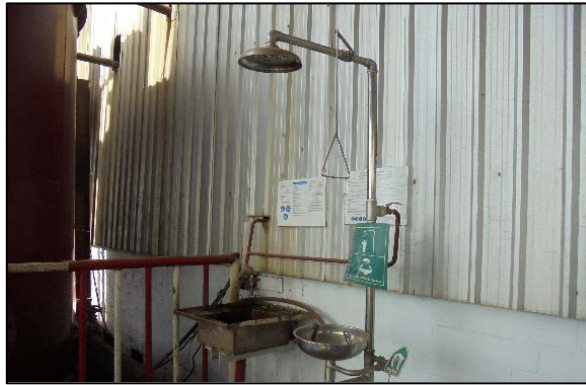
รูปที่ 73 อ่างล้างตา/ล้างหน้า ฝักบัวฉุกเฉิน
