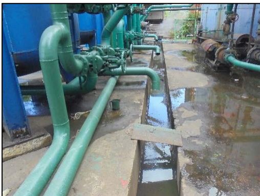
รูปที่ 36 ระบบระบายน้ำฝนปนเปื้อน
