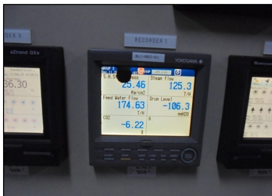
รูปที่ 77 ตรวจวัดอุณหภูมิและความดันทั้งขาเข้า-ขาออกจากกังหันไอน้ำ
