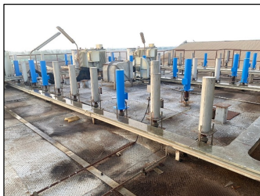
รูปที่ 6 อะไหล่และอุปกรณ์ซ่อมบำรุงระบบดักฝุ่นละอองจากหม้อไอน้ำ
