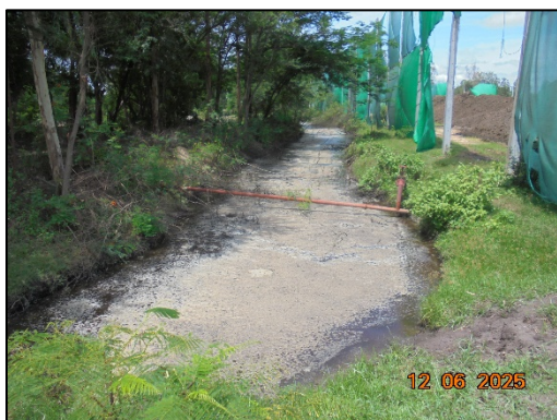
รูปที่ 48 ระบบระบายน้ำรอบบริเวณลานกองเถ้าและลานกองขานอ้อย
