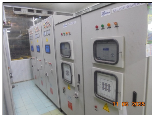
รูปที่ 4 อุปกรณ์ตรวจวัดกระแสไฟฟ้า ของเครื่องดักฝุ่นแบบไฟฟ้าสถิต (ESP)
