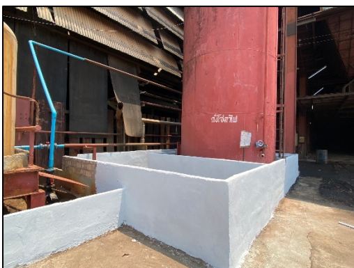
รูปที่ 75 ถังคอนกรีตรอบบริเวณถังเก็บกากสารเคมีของเหลว
