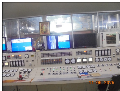
รูปที่ 4 อุปกรณ์ตรวจวัดกระแสไฟฟ้า ของเครื่องดักฝุ่นแบบไฟฟ้าสถิต (ESP)
