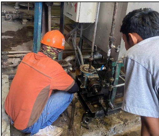
รูปที่ 74 ตรวจสอบข้อต่อ วาล์ว และปั๊ม ถังเก็บสารเคมี
