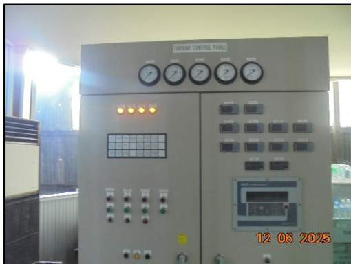
รูปที่ 76 อุปกรณ์ตรวจวัดต่างๆ เพื่อตรวจสอบการทำงานของหน่วยผลิตไอน้ำ
