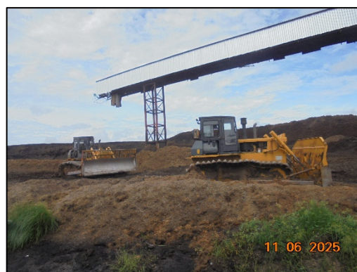
รูปที่ 14 สายพานลำเลียงขนถ่ายระบบปิดครอบ
