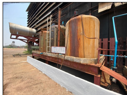
รูปที่ 75 ถังคอนกรีตรอบบริเวณถังเก็บกากสารเคมีของเหลว
