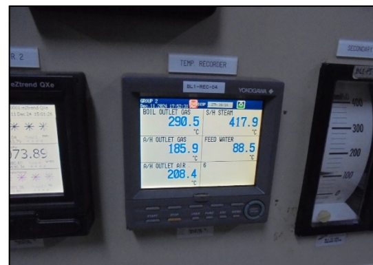
รูปที่ 77 ตรวจวัดอุณหภูมิและความดันทั้งขาเข้า-ขาออกจากกังหันไอน้ำ
