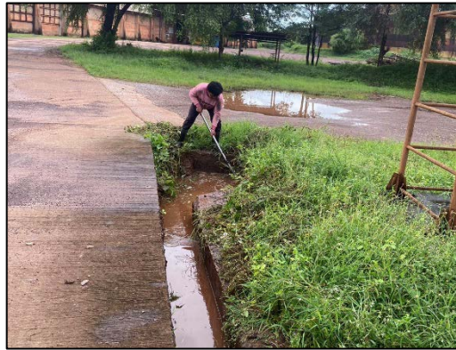
รูปที่ 49 การขุดลอกรางระบายภายในพื้นที่โครงการ
