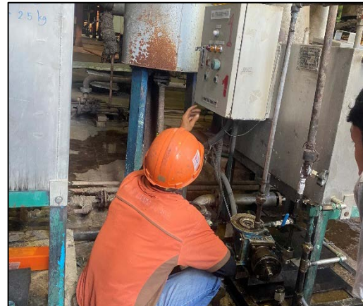
รูปที่ 74 ตรวจสอบข้อต่อ วาล์ว และปั๊ม ถังเก็บสารเคมี
