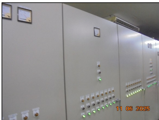
รูปที่ 4 อุปกรณ์ตรวจวัดกระแสไฟฟ้า ของเครื่องดักฝุ่นแบบไฟฟ้าสถิต (ESP)
