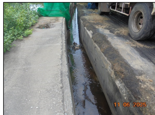
รูปที่ 35 ระบบระบายน้ำเดียวของโครงการ
