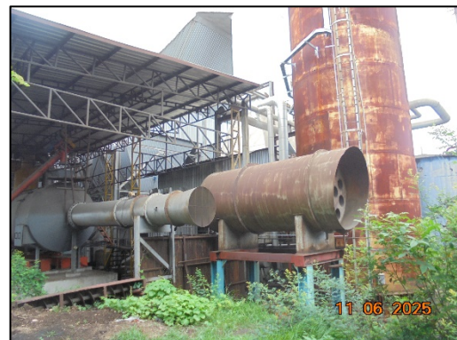
รูปที่ 25 อุปกรณ์ลดเสียง (Silencer) บริเวณที่มีเสียงดัง
