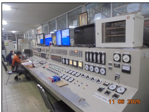
รูปที่ 4 อุปกรณ์ตรวจวัดกระแสไฟฟ้า ของเครื่องดักฝุ่นแบบไฟฟ้าสถิต (ESP)
